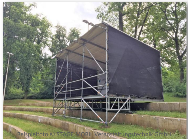
FoH 6,21 m x 3,86 m als Stufenüberbauung
